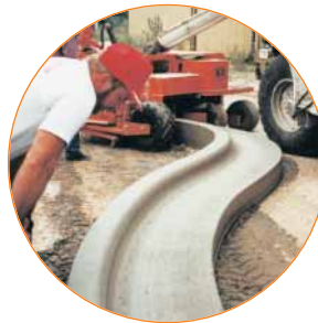
Pavimentadora de encofrado deslizante
